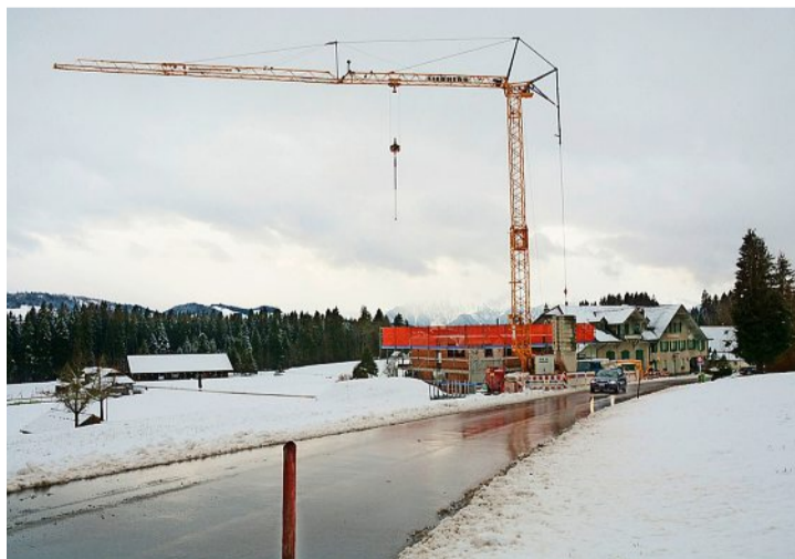
Im Rohrimoos sind Baumaschinen aufgeföhren. Foto: Stefan Kammermann
